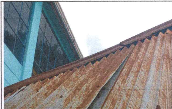
Foto 2: sustitucion de capotes de lamina para lamina troquelada
