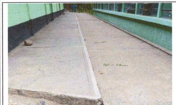
Foto 5: Reparación de piso de torta de concreto corredor de las aulas modulo 1 y 2
