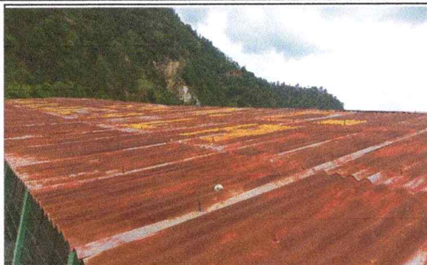
Foto1: sustitucion de lamina, por lamina troquelada Alucinc calibre 26
