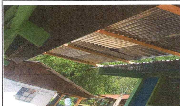
Foto 3: sustitucion de estructura de soporte de madera por metal
